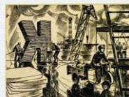
Дубровин И.В. г. Самара «КВЦ. Монтажные работы на крыше» Цинкография Фонд музея АО «АВТОВАЗ»
